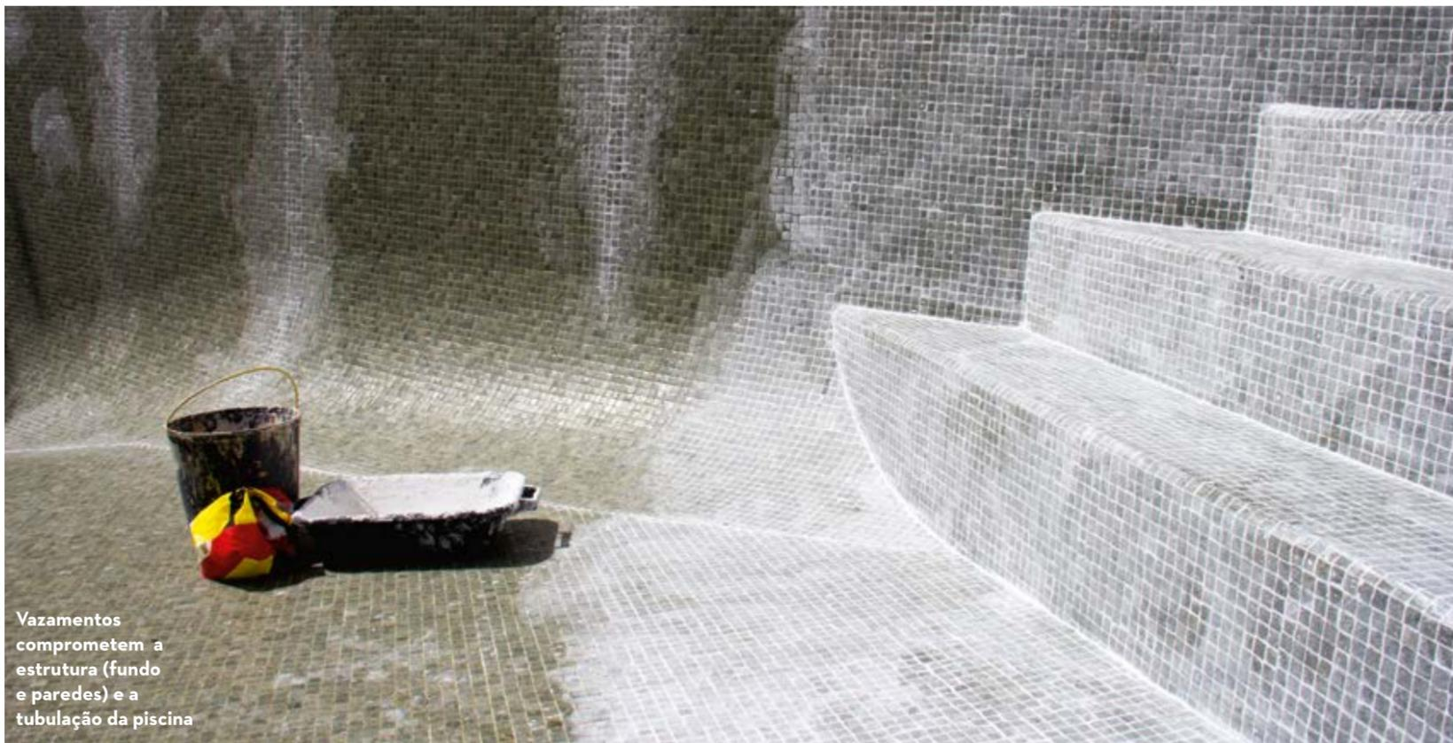
Vazamentos comprometem a estrutura (fundo e paredes) e a tubulação da piscina
